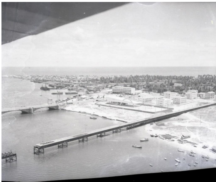
Figura 13 – Obras na Bacia do Pina no ano de 1966
