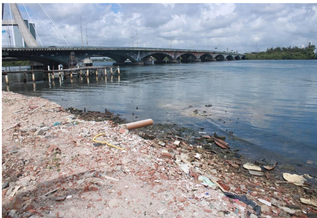
Figura 21 –Tubulação ativa de esgoto despejando dejetos diretamente nas águas da Bacia do Pina
