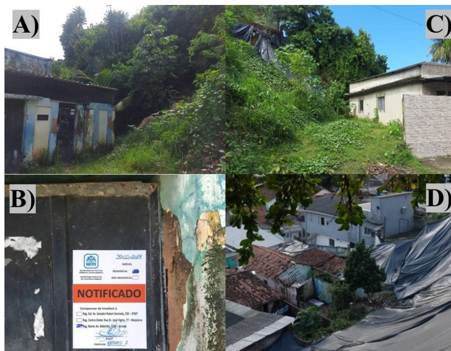
Figura 6 - Casas notificadas pela Secretaria Municipal de Defesa Civil, na Bomba do Hemetério-Recife.
