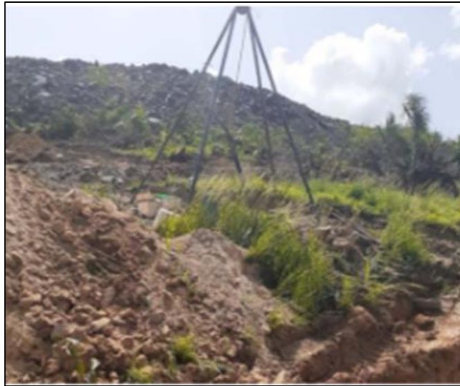
Figura 1 – Sondagem à percussão
