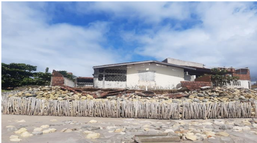
Figura 10 – Contenção de enrocamento no trecho de Praia Azul
