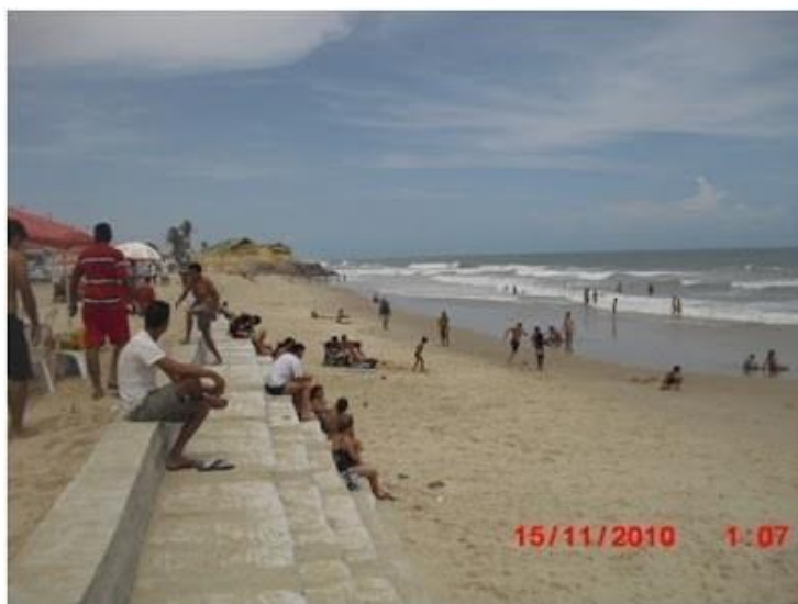
Figura 5 – Praia do Icaraí, com contenção Bagwall
