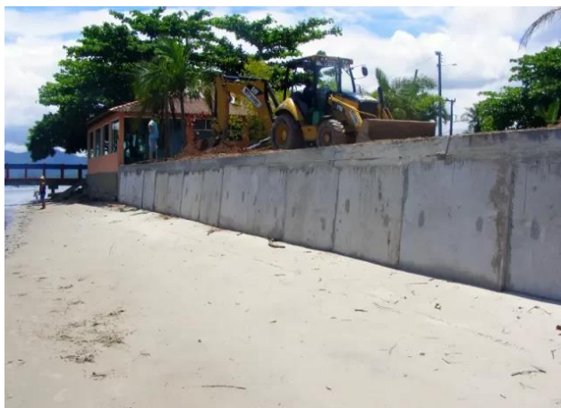
Figura 3 – Muro de Arrimo
