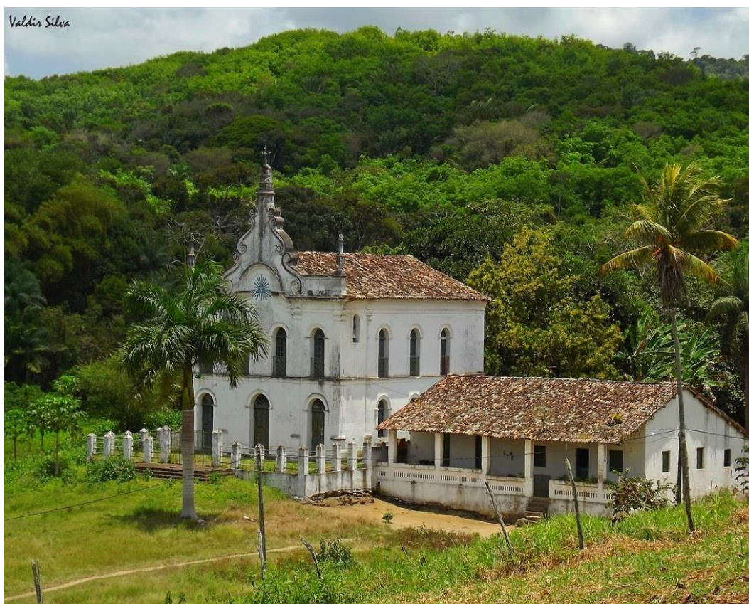
Figura 1 – Engenho Gaipió na cidade de Ipojuca
