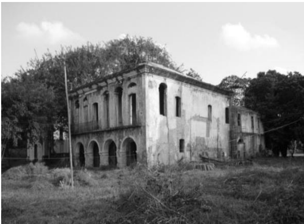
Figura 9 – Engenho Monjope na cidade de Igarassu
