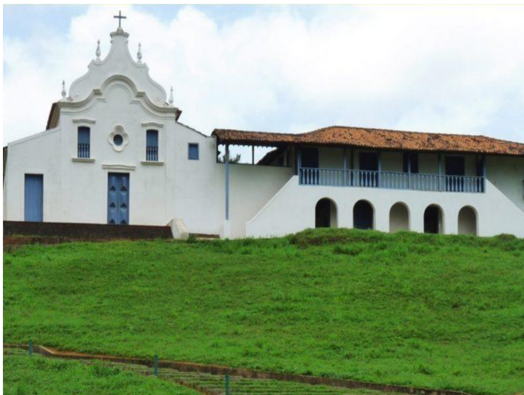
Figura 10 – Engenho Poço Cumprido na cidade de Vicência
