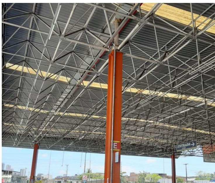
Figura 1: Treliza utilizada na cobertura de um galpão
