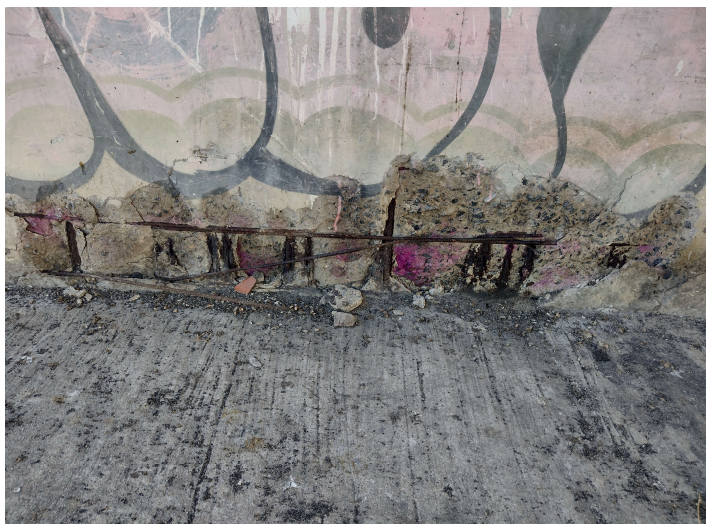
Figura 3. Área do pilar 2
