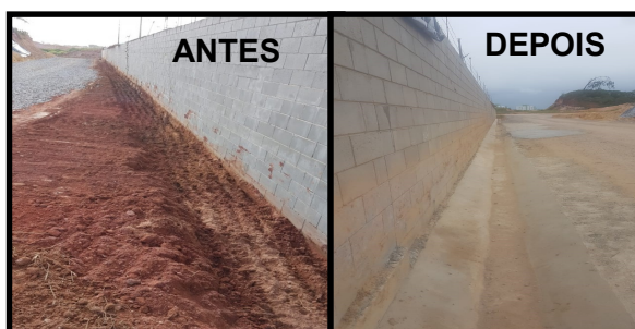
Figura 01: Execução do serviço de calha
