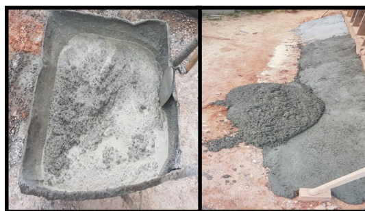
Figura 06: Sobra Slump Test
