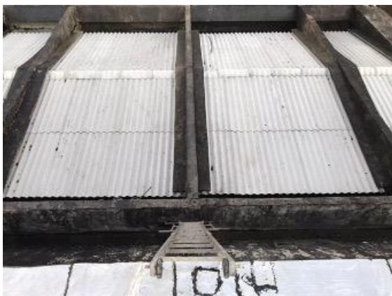
Figura 15: Aplicação da camada de prime.
