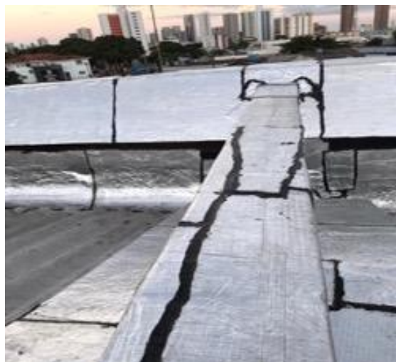
Figura 16: Manta alumínio aplicada sobre estrutura de concreto.
