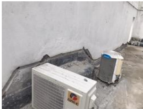
Figura 13: Execução do corte na alvenaria.
