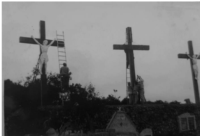
Imagem 11: Construção do Calvário, processo de finalização do ambiente.
