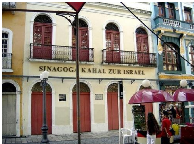
Figura 18: Fachada da Sinagoga Kahal Zur Israel
