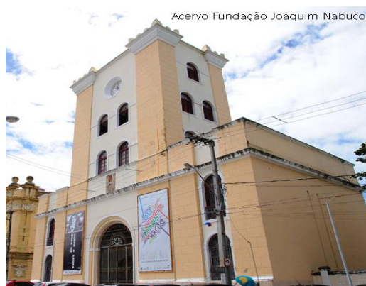
Figura 17: Fachada Torre Malakoff
