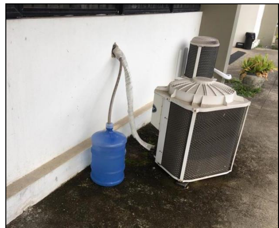
Figura 4 - Coleta de água condensada gerada por aparelho condicionador de ar por tubo flexível
