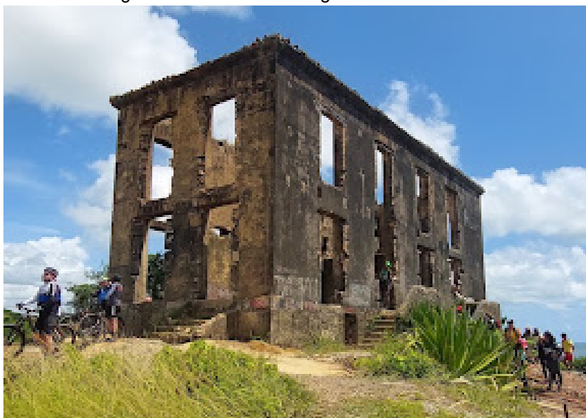
Figura 08 — Ruína da antiga Casa do Faroleiro
