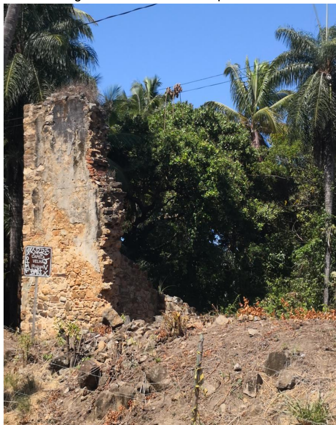
Figura 11 — Ruína da Capela Velha
