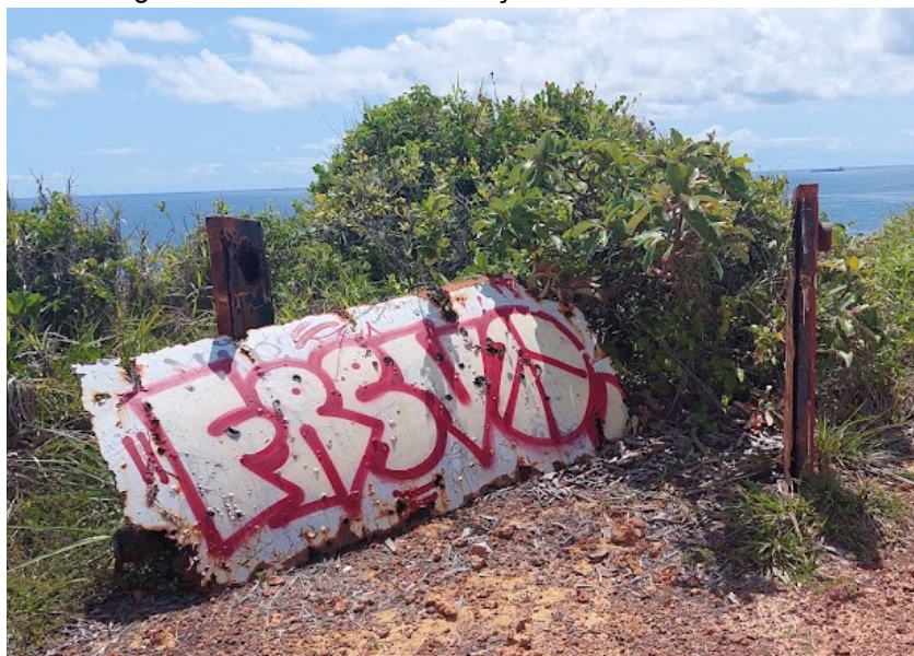
Figura 03 — Placa de sinalização na Casa do Faroleiro
