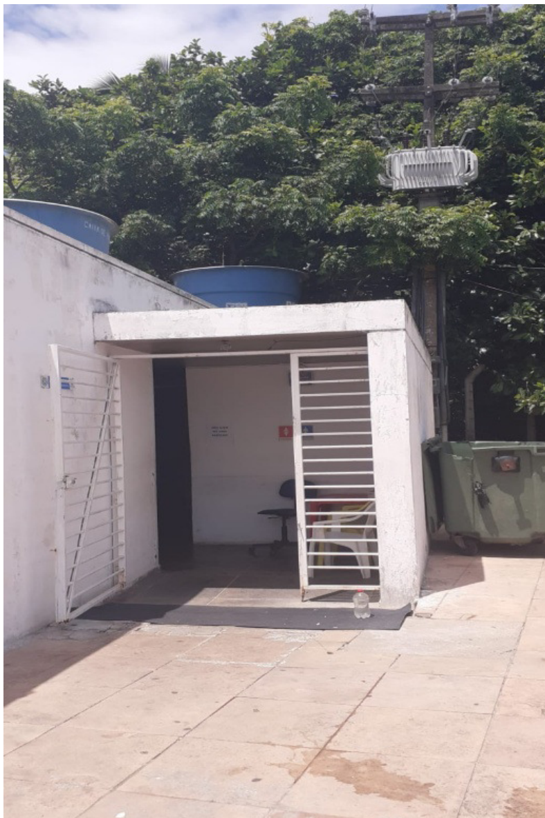
FIGURA 29 - ENTRADA DOS BANHEIROS
