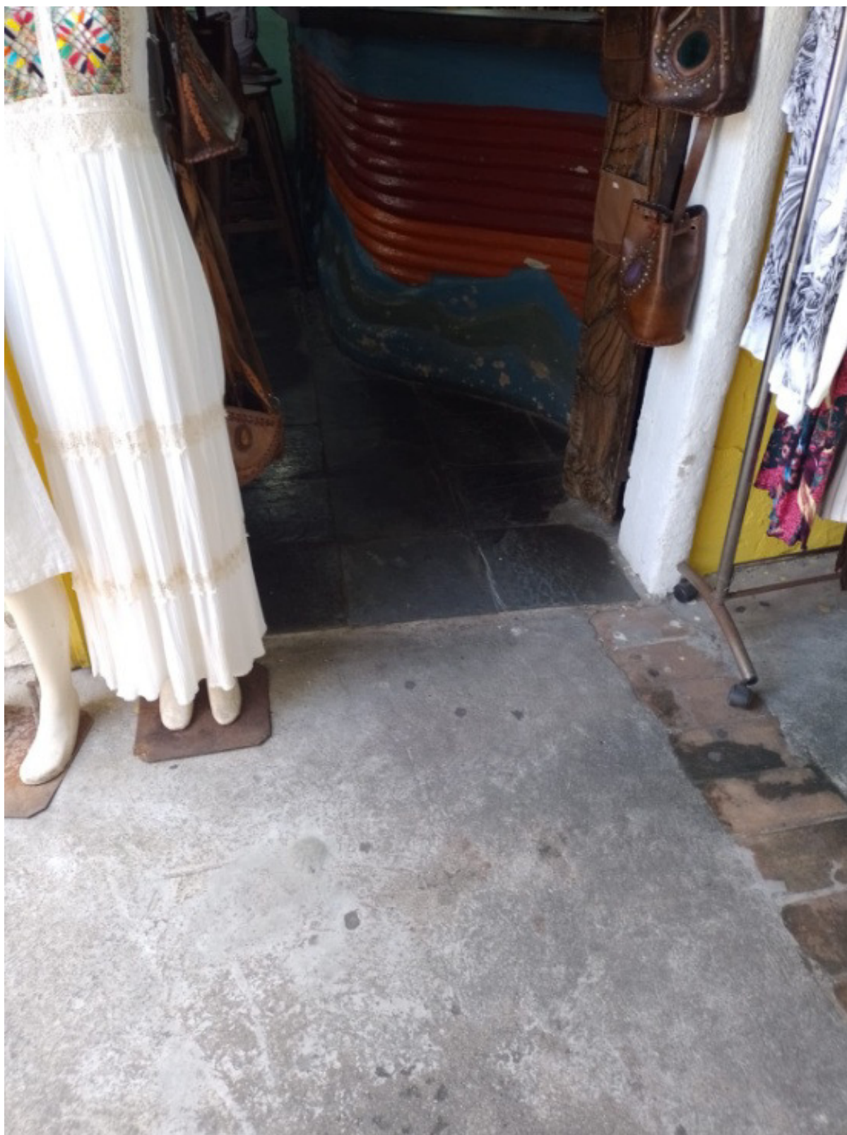
FIGURA 37 - ENTRADA DO ARTE BAR RESTAURANTE 2
