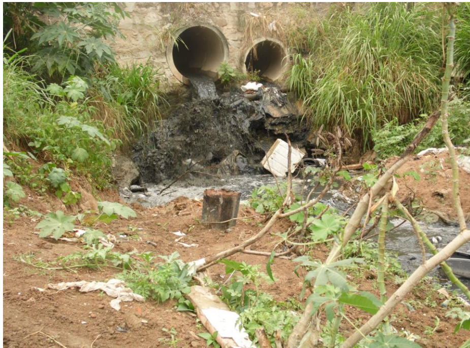
Figura 19 – Esgotamento sanitário disposto no rio Tapacurá. Bairro do Jardim Ipiranga (Localidade Mário Bezerra). Ponto de Degradação 2 (PD 2).
