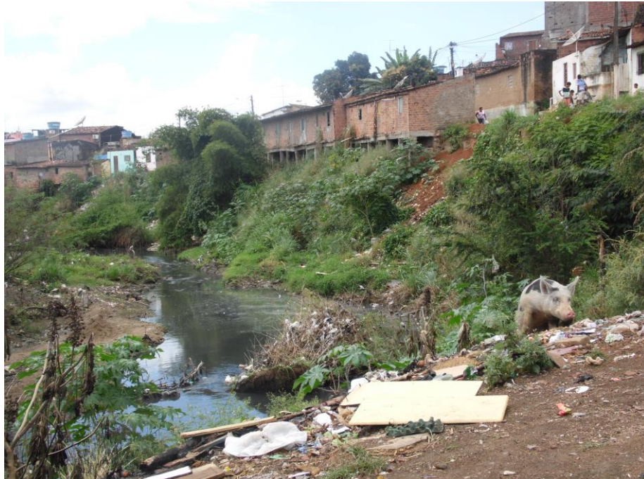
Figura 20 – Acúmulo de resíduos sólidos, presença de animais e erosão da margem do rio. Bairro do Jardim Ipiranga (Localidade Mário Bezerra). Ponto de Degradação 3 (PD 3).
