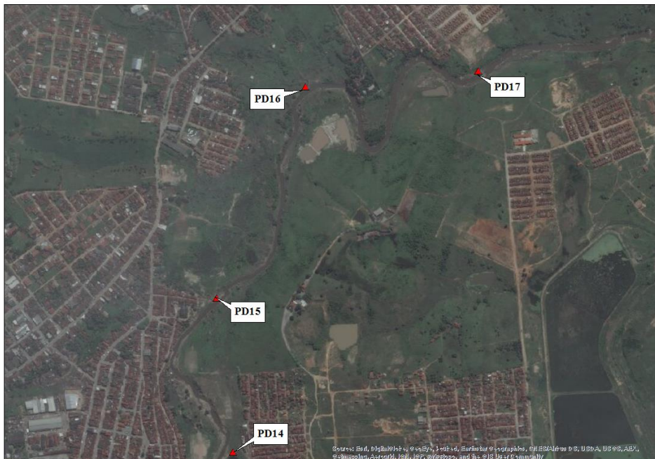
Figura 41 – Ponto de Degradação 15 (PD 15) no bairro do Cajá e Pontos 16 e 17 (PD 16 e PD 17) no bairro de Águas Brancas.
