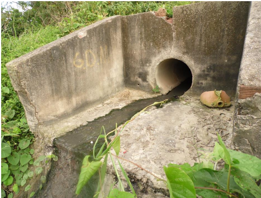
Figura 34 – despejo de esgotamento sanitário direto no rio. Bairro de Água Branca (Localidade Militina). Ponto de Degradação 17 (PD 17).
