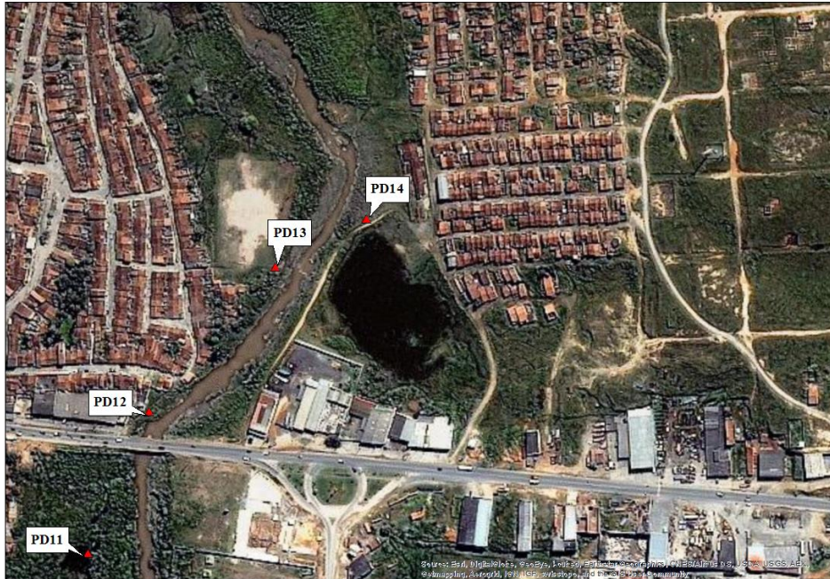
Figura 40 – Pontos de Degradação 12 e 13 (PD 12, PD 13) no bairro do Cajá e Ponto 14 (PD 14) no bairro de Conceição.
