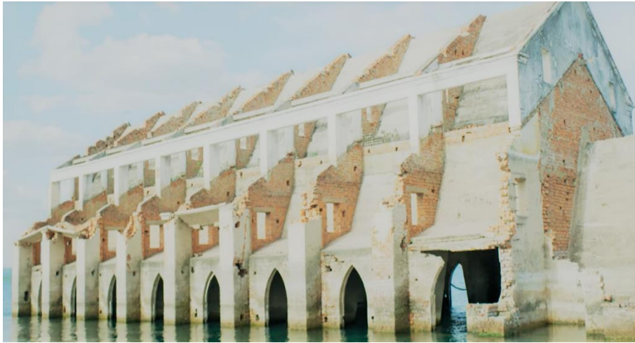
FIGURA 40 – Igreja submersa do Sagrado Coração, Petrolândia - PE
