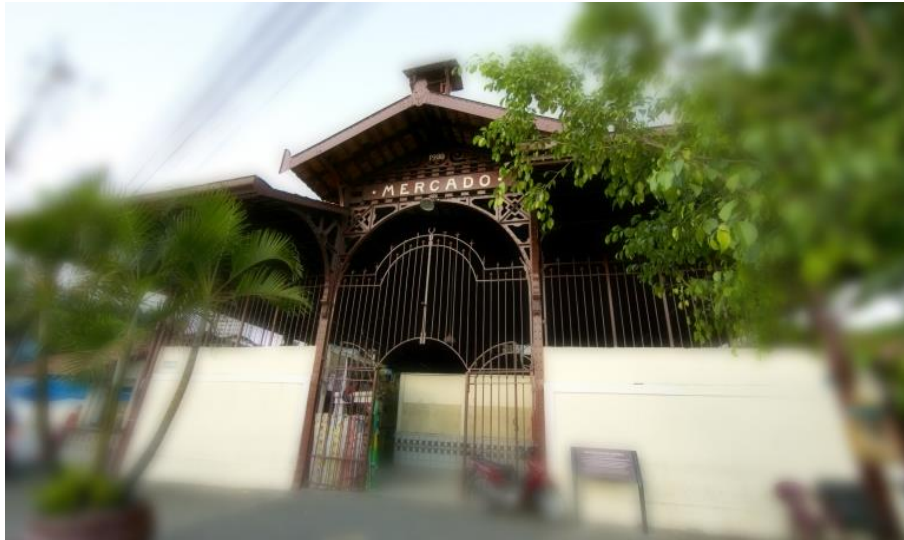
Figura 4 – Entrada do MPCA - Principal Fonte: CSURB (2018).
