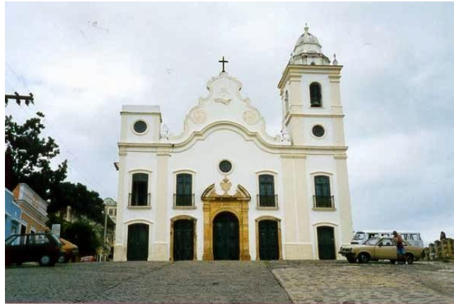
Figura 20 - Igreja de Nossa Senhora do Amparo
