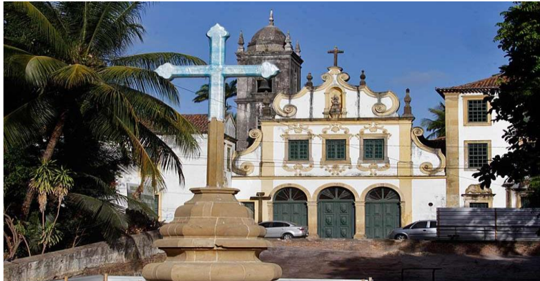
Figura 25 - Convento de São Francisco/Igreja de Nossa Senhora das Neves
