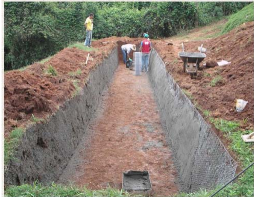
Figura 5 - Técnica argamassa armada em uma BET
