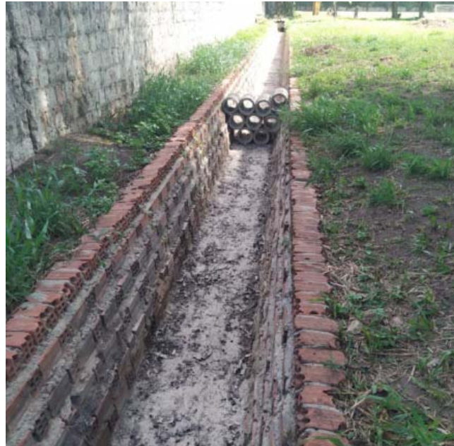
Figura 18 – Canal de Microdrenagem do IFPE – Campus Recife
