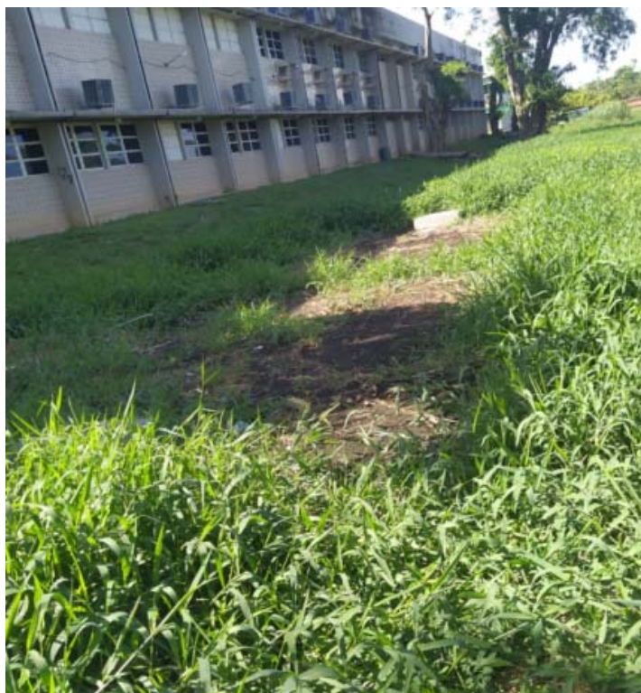
Figura 15 – Fossa séptica do Instituto (IFPE)
