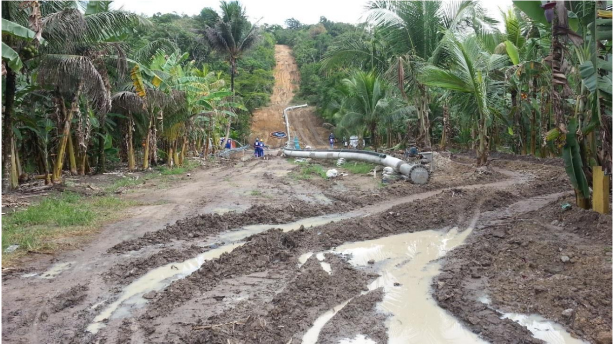
Figura 20 – Evidência de processos erosivos em declividades entre 15° e 45° resultante de ação antrópica
