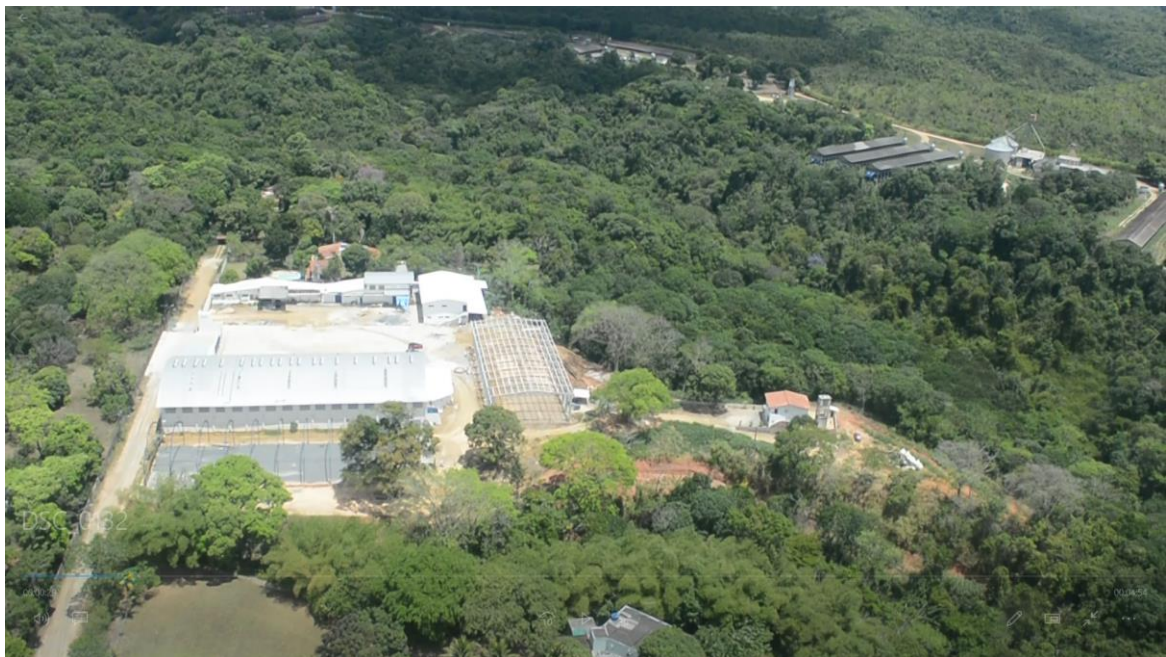
Figura 50 - Detalhamento das instalações industriais diversificadas nas bordas dos Tabuleiros.
