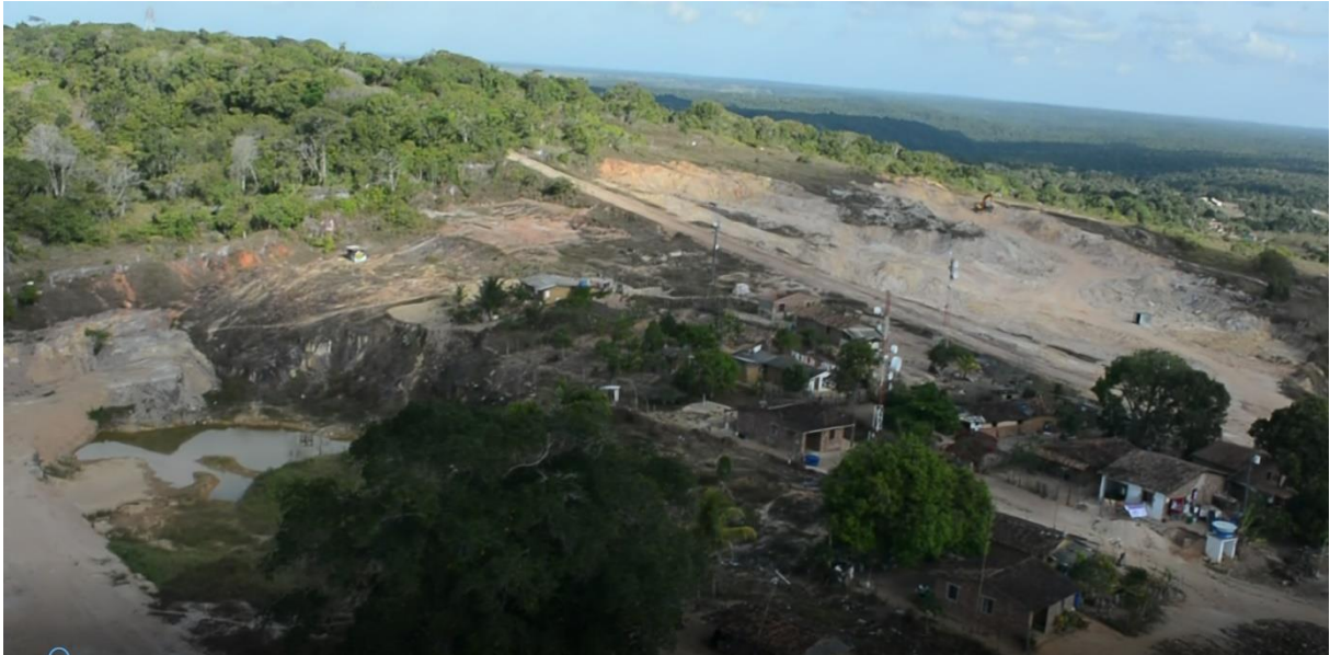
Figura 26 – Morro de Miritiba no Tabuleiro. Processo erosivo. Região de Aldeia.
