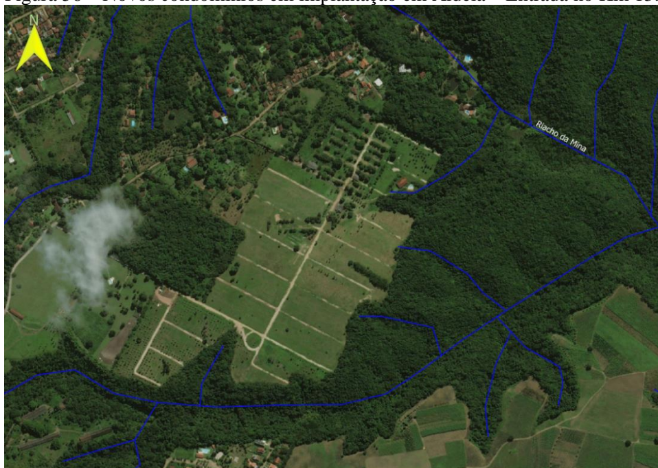
Figura 56 – Novos condomínios em implantação em Aldeia – Entrada no Km 13.
