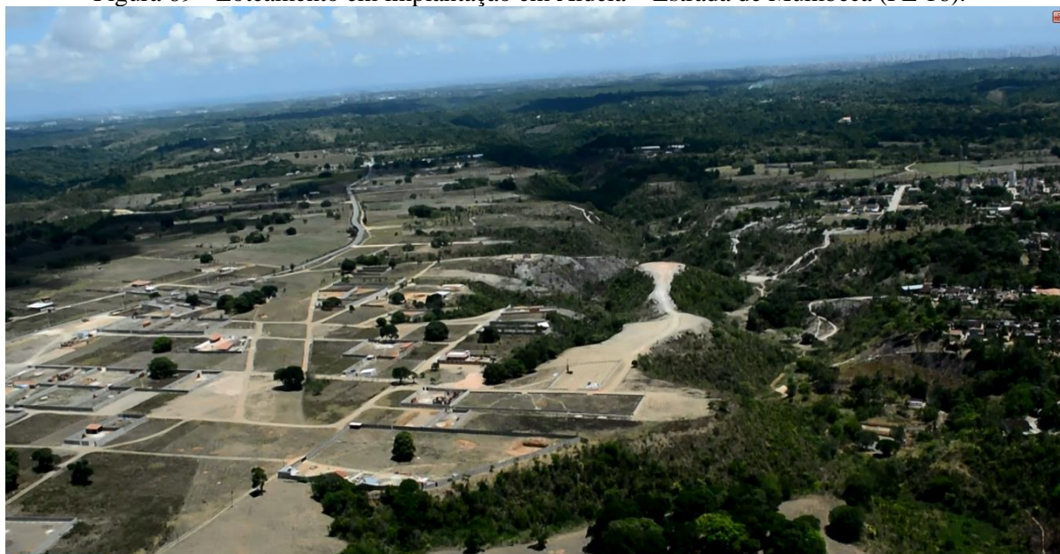
Figura 69 - Loteamento em implantação em Aldeia – Estrada de Mumbeca (PE 16).
