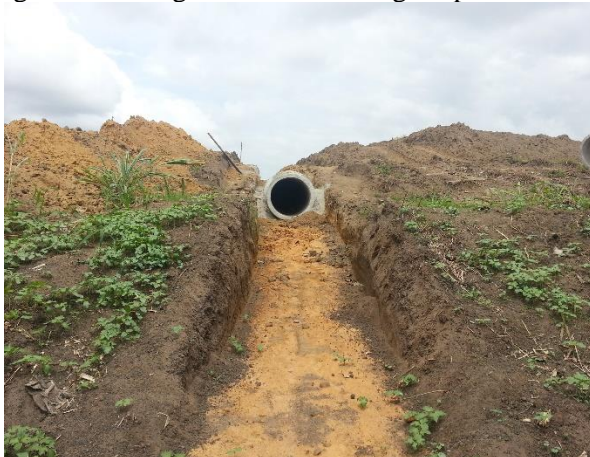
Figura 67 - Imagens do dreno de águas pluviais canalizadas para um talvegue formador do rio Besouro
