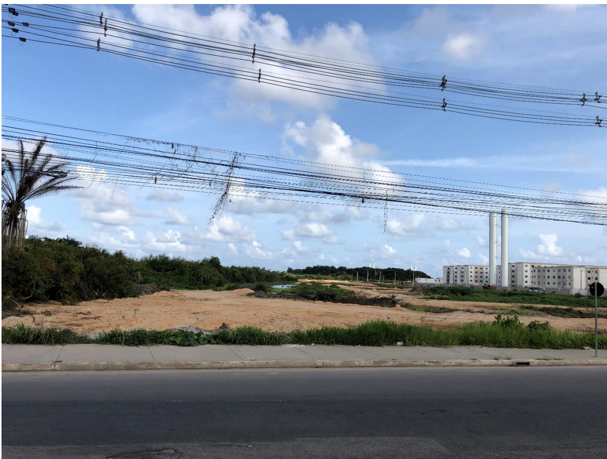
Figura 14 – Aterramento de área do Canal das Tintas dentro dos limites da ZECUA do Rio Paratibe em Paulista, Pernambuco
