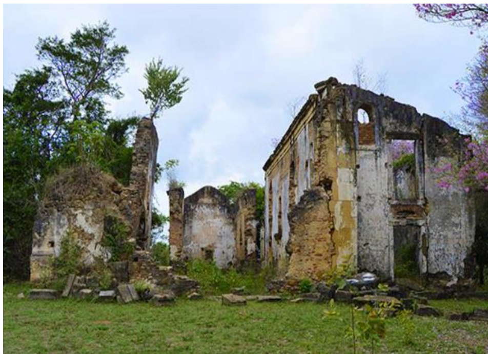
Figura 4 - Fachada frontal da Igreja de Nossa Senhora dos Prazeres em Paulista, Pernambuco
