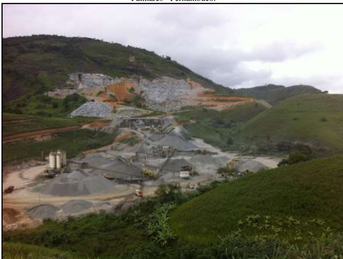
Figura 20: Área da pedreira durante a exploração mineral para a Construção da barragem Serro Azul em Palmares - Pernambuco.
