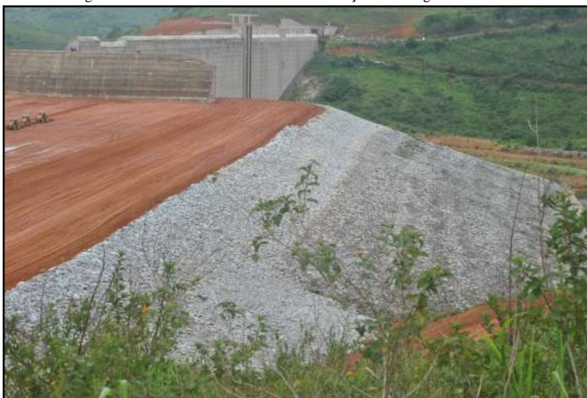
Figura 19: Uso do material mineral na Construção da barragem Serro Azul.
