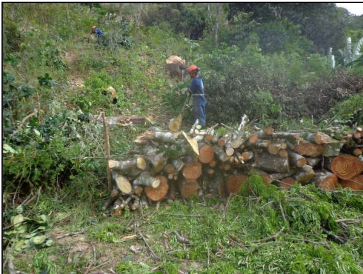
Figura 09: Operadores de motosserra em atuação em campo durante a supressão vegetal para a construção da Barragem Serro Azul.
