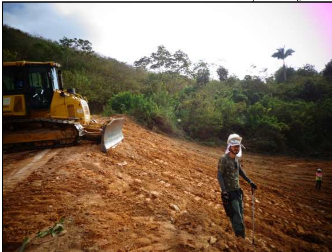
Figura 08: Trator de esteira atuando em áreas declivosas situadas na área de limpeza da barragem Serro Azul.
