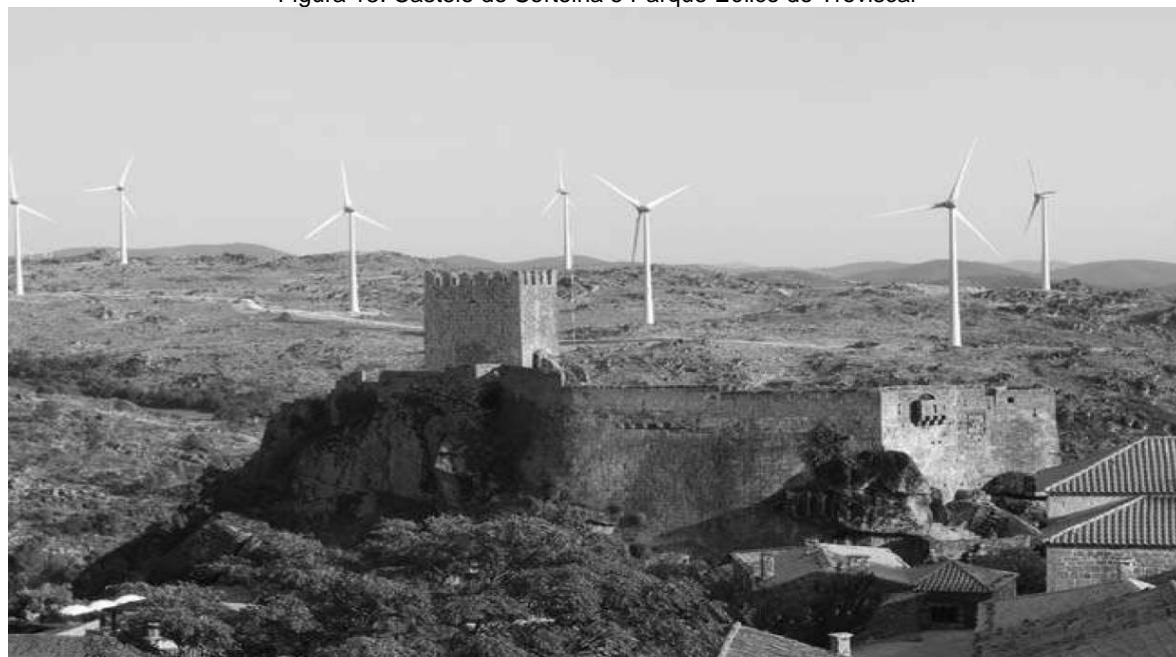
Figura 13: Castelo de Sortelha e Parque Eólico do Troviscal
