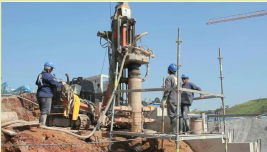
Estaca Raiz - Metodologia e Execução
