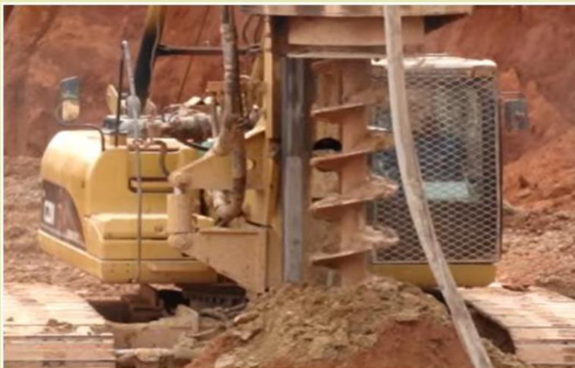
Fundação em Estacas Hélice Contínua
