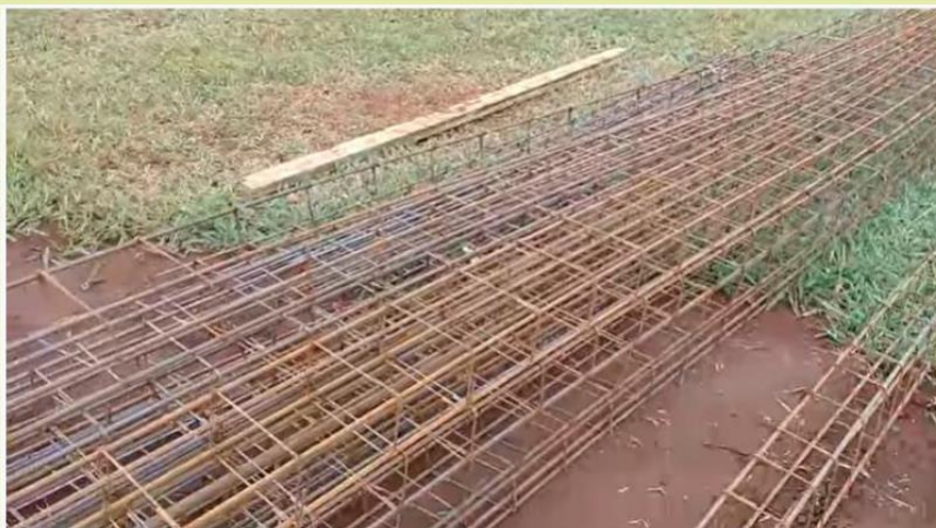
# 24 Como fazer Ferragens da Estrutura (brocas, viga baldrame e blocos)
