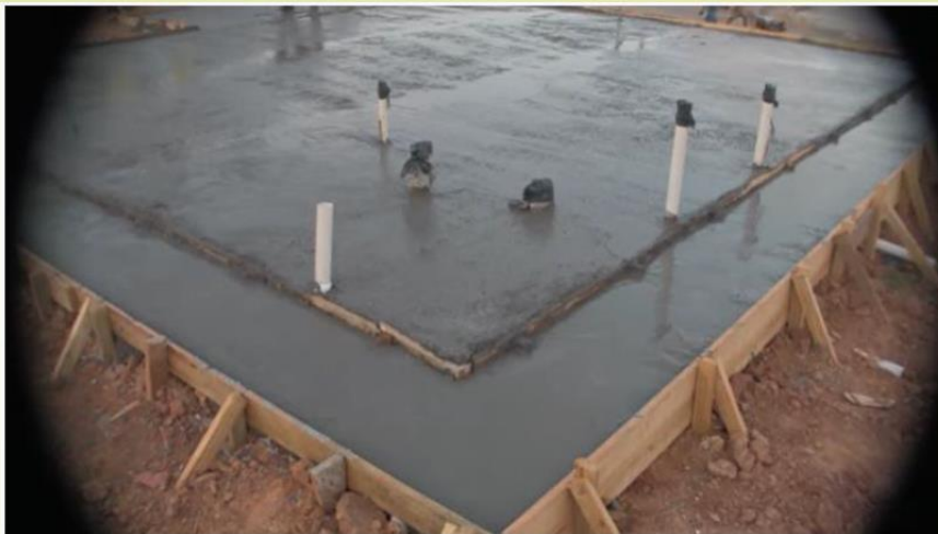
FUNDAÇÃO RADIER - STEEL FRAME
