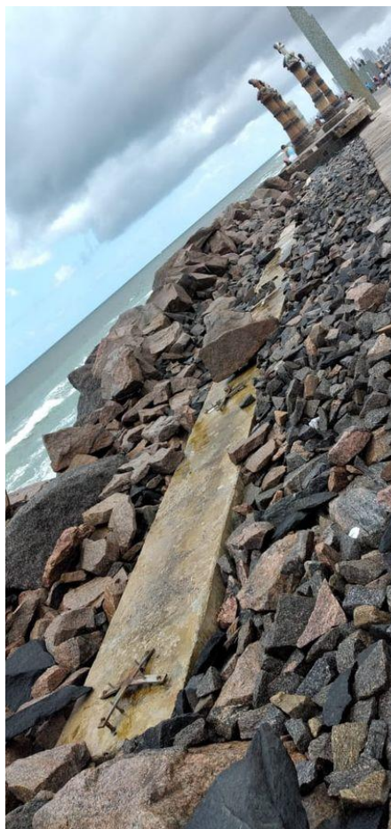
Fotografia 3 — Estrutura onde estava a obra Serpente Marinha, com 22 metros de comprimento, furtada em 2020.
