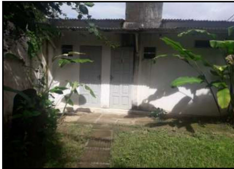
Figura 21 - Banheiros da área externa
