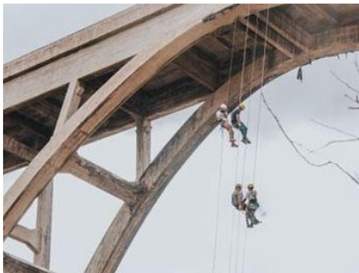
FIGURA 23- Rapel Ponte Cascavel
