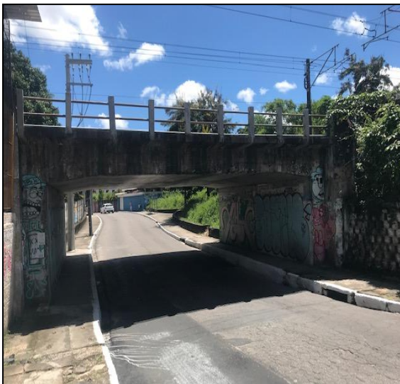
Figura 23 - Vigas Invertidas - Vigas da estrutura Nível "A"
