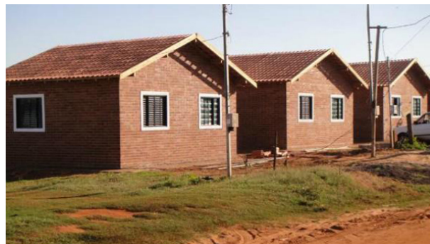
Figura 06-Casas padrão popular construídas com tijolos ecológicos
