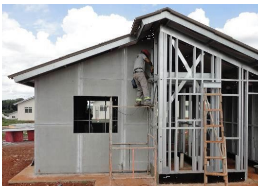
Figura 11-Casa em Steel Frame
