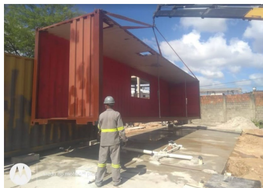
Figura 08-Container marítimo pré-executado posicionado em fundação com infraestrutura
