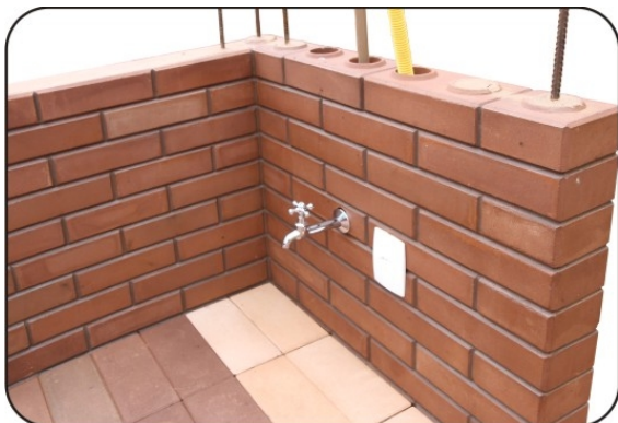
Figura 05-Detalhe tijolos ecológicos com armação e instalações
