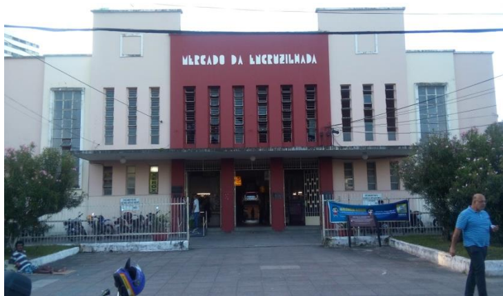
Figura 3. Imagem da fachada do Mercado Público da Encruzilhada, Recife – PE.
