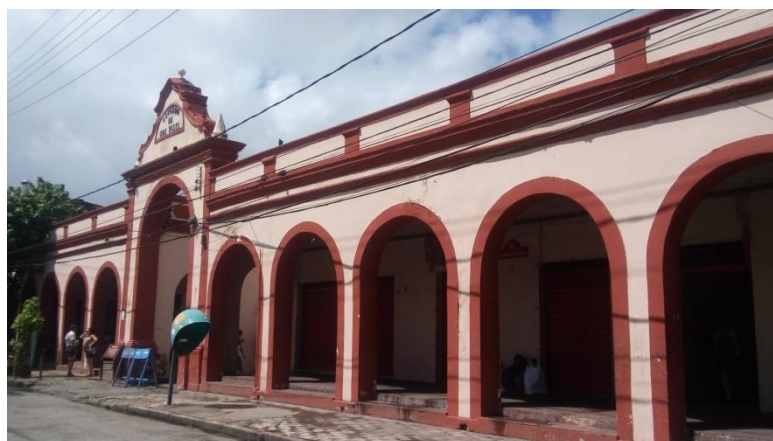
Figura 2. Imagem da fachada do Mercado Público da Boa Vista, Recife – PE.
