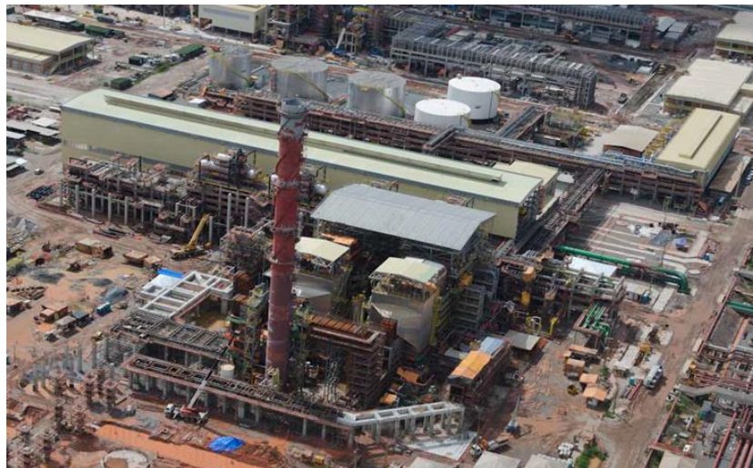
Figura 21 – Vista aérea da Casa de Força – CAFOR da RNEST
