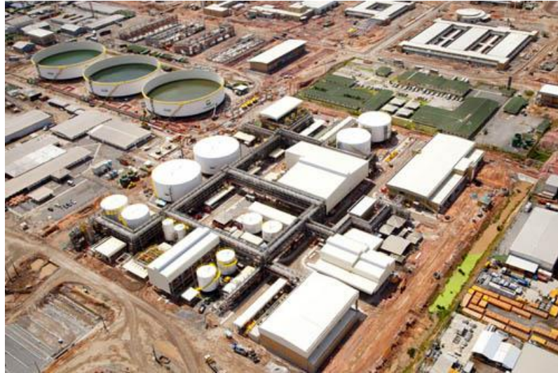
Figura 13 – Vista aérea da Estação de Tratamento de Água da RNEST
