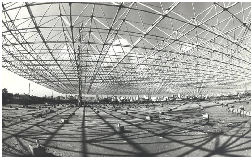
Figura 3 - Construção do Centro de Convenções Anhembi
