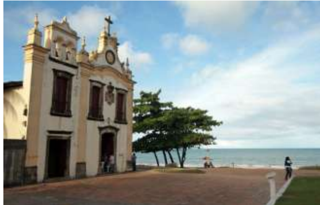
Figura 19: Fachada da Igreja Nossa Senhora de Piedade
