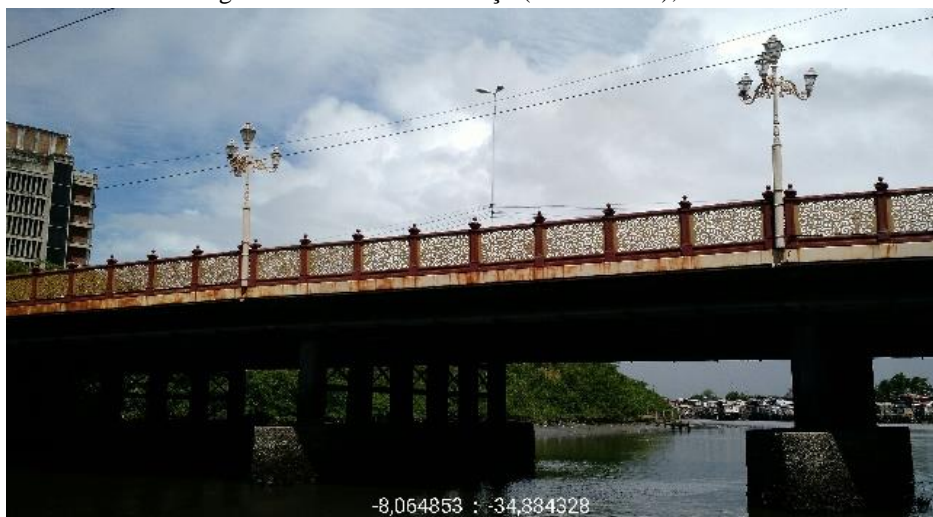
Figura 53 – Ponte 6 de Março (Ponte Velha), Recife
