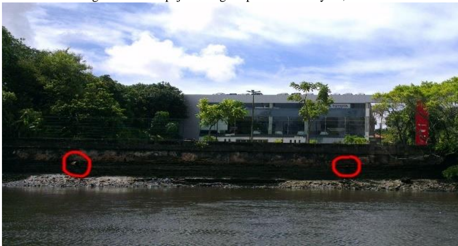
Figura 75 – Despejo de Esgoto por traz da Toyota, Recife
