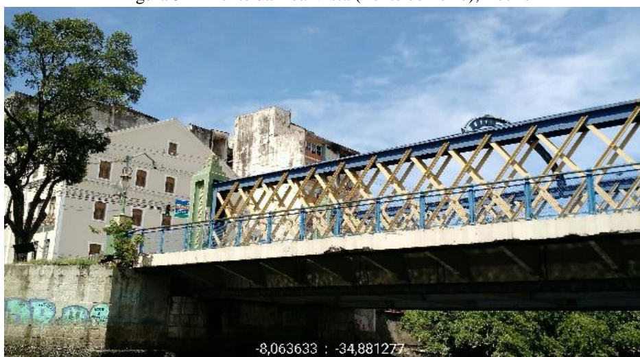
Figura 54 – Ponte da Boa Vista (Ponte de Ferro), Recife
