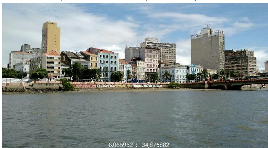
Figura 49 – Prédios Coloniais, Rua da Aurora, Recife
