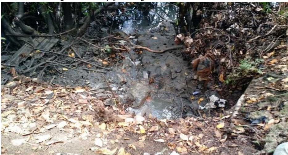
Figura 74 – Despejo de Esgoto no Jardim Baobá, Recife
