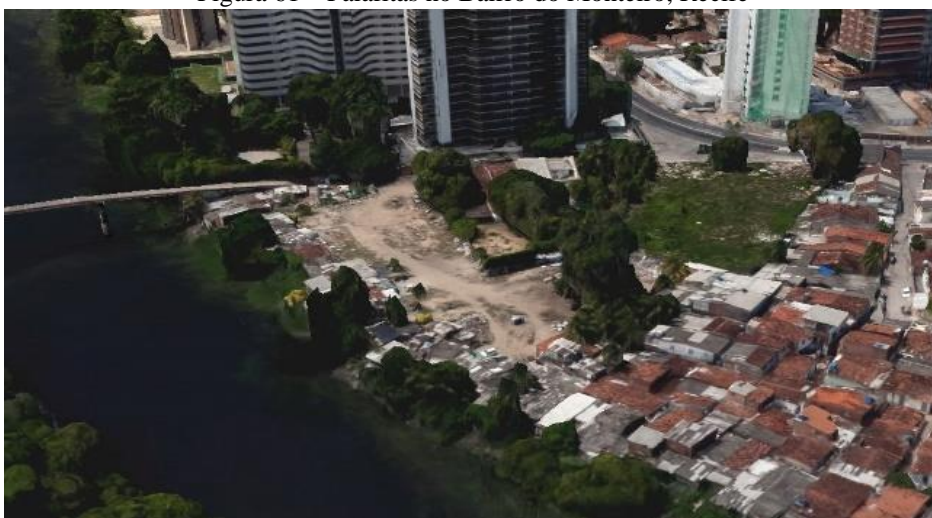
Figura 61 – Palafitas no Bairro do Monteiro, Recife
