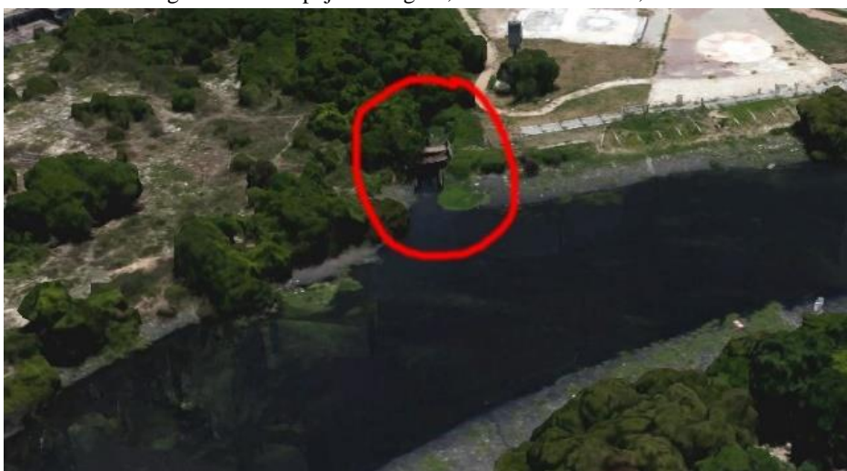
Figura 69 – Despejo de Esgoto, Canal do Cavouco, Recife
