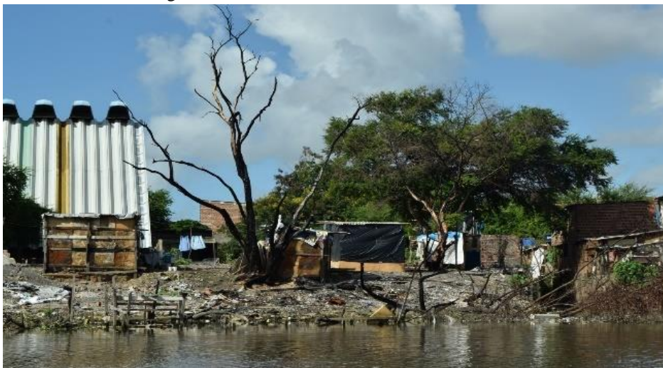
Figura 62 – Palafitas na Vila Santa Luzia, Recife
