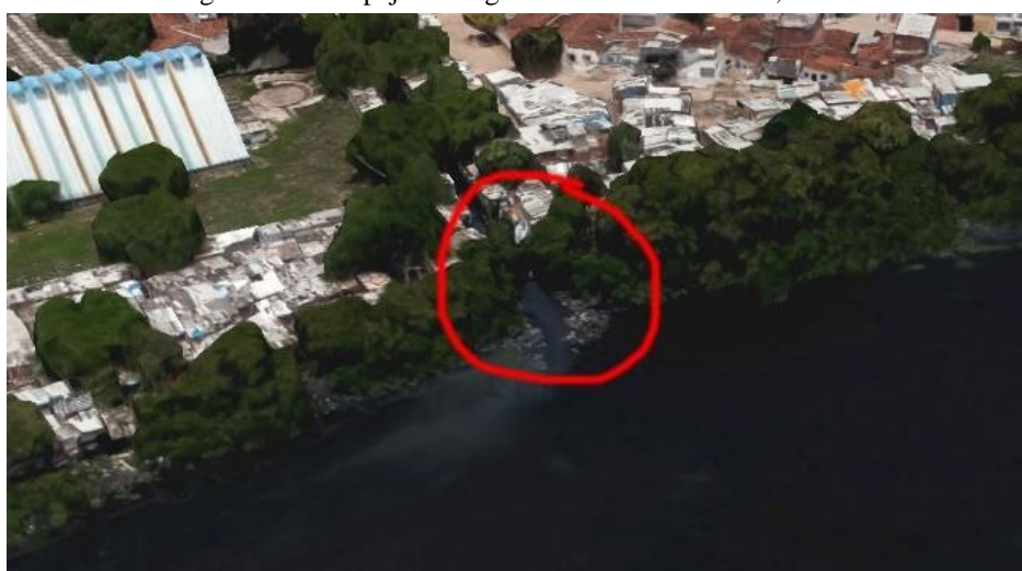
Figura 71 – Despejo de Esgoto na Vila Santa Luzia, Recife
