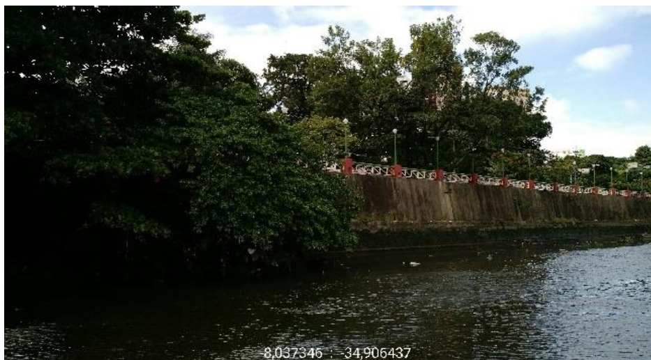
Figura 43 – Dique da Av. Rui Barbosa, Jaqueira, Recife
