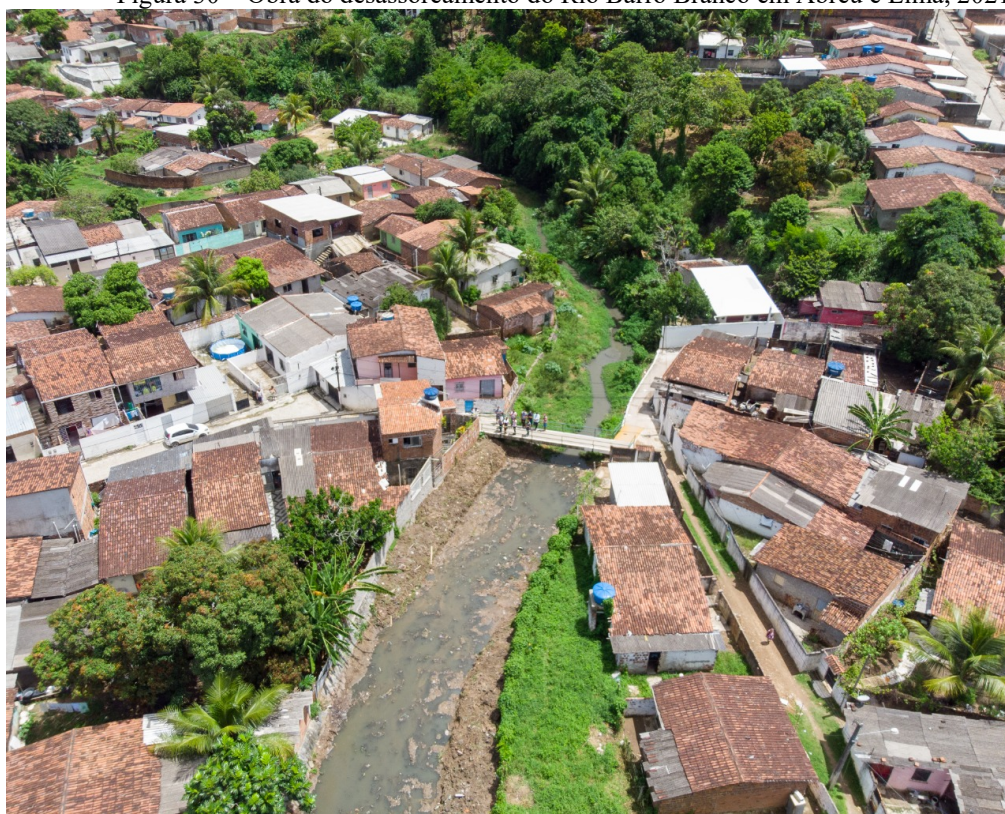
Figura 30 – Obra do desassoreamento do Rio Barro Branco em Abreu e Lima, 2021
