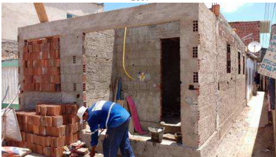
Figura 45 - Casa nova em construção com prazo determinado para finalização em janeiro de 2017
