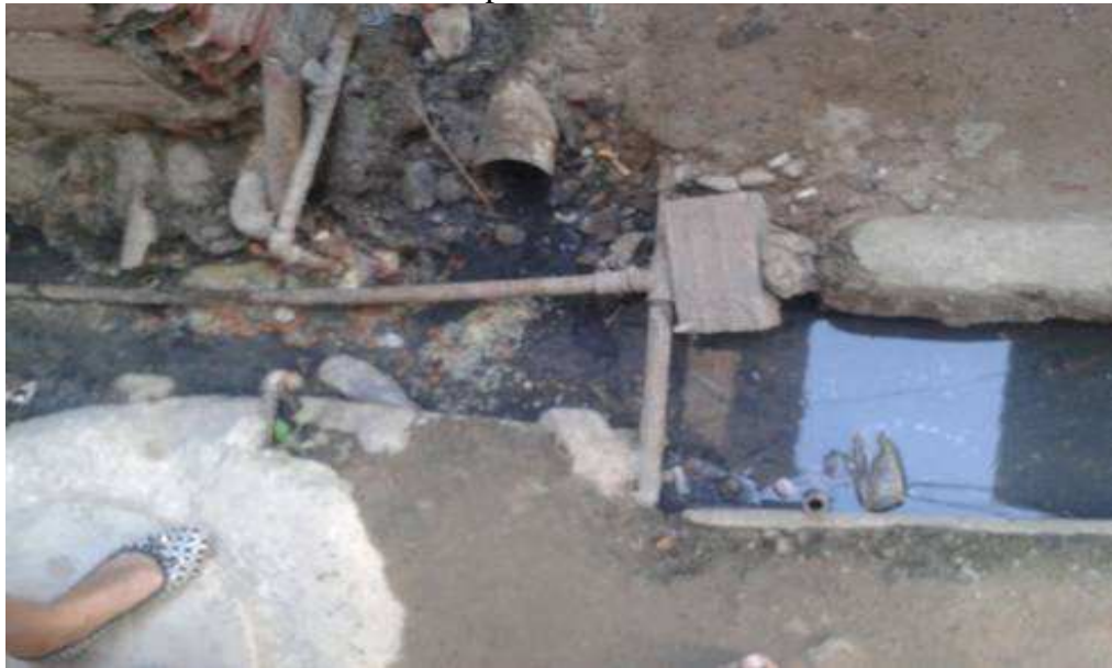
Figura 6 - Ausência de esgotamento na comunidade obrigando que os resíduos estejam expostos na rua
