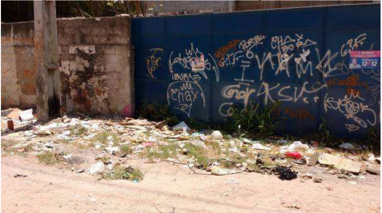
Figura 15: Registro de acúmulo de lixo em locais inadequados na comunidade
