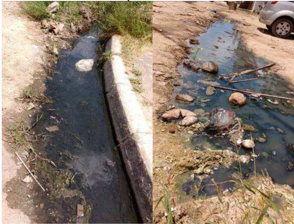
Figura 8 e 9 - Ausência de esgotamento na comunidade obrigando que os resíduos estejam expostos na rua
