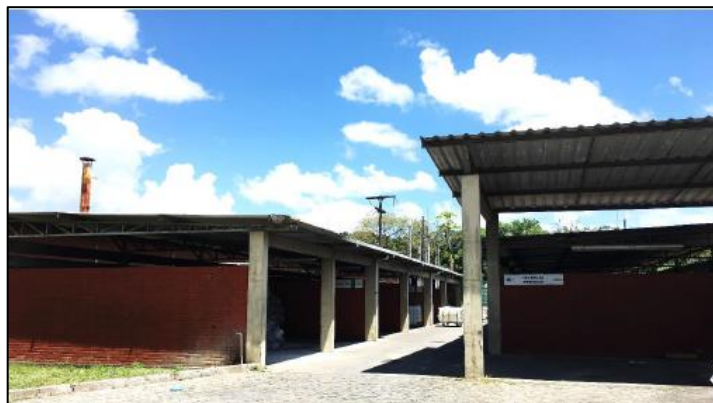
Figura 02: Central de Recebimento de Resíduos da empresa
