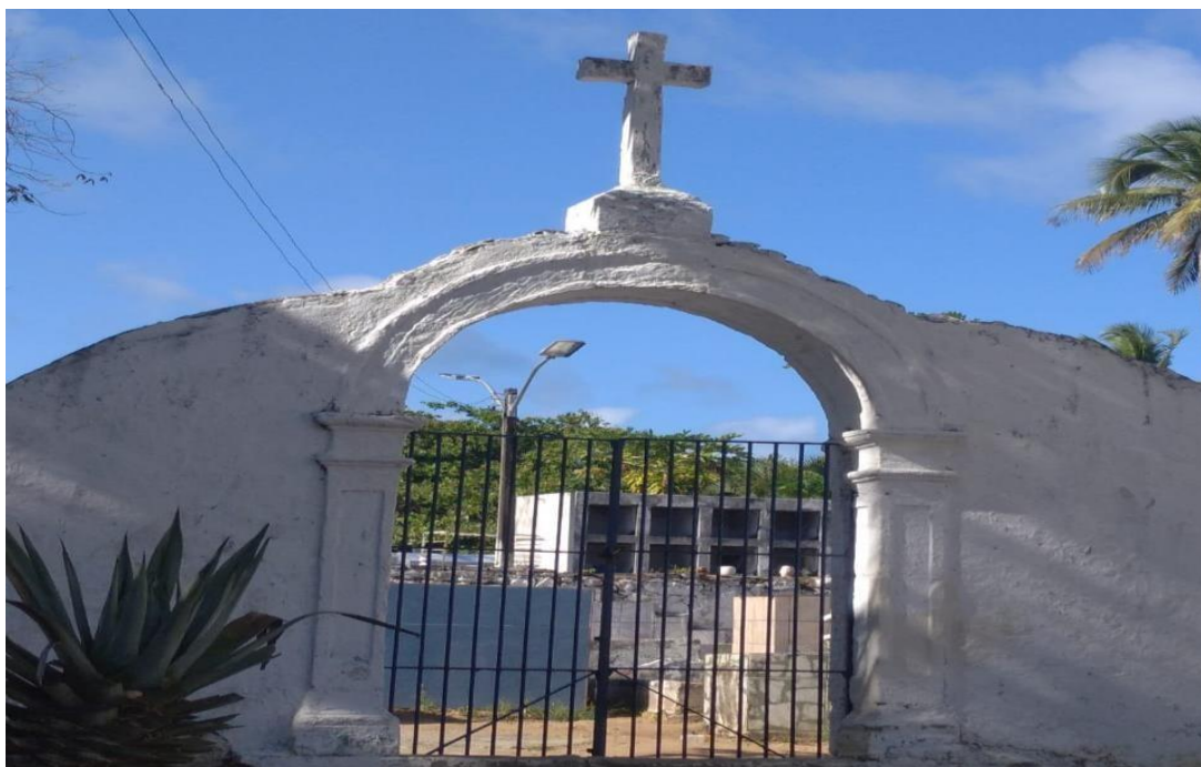
Figura 15 - Cemitério anexo a Igreja Nossa Senhora de Nazaré
