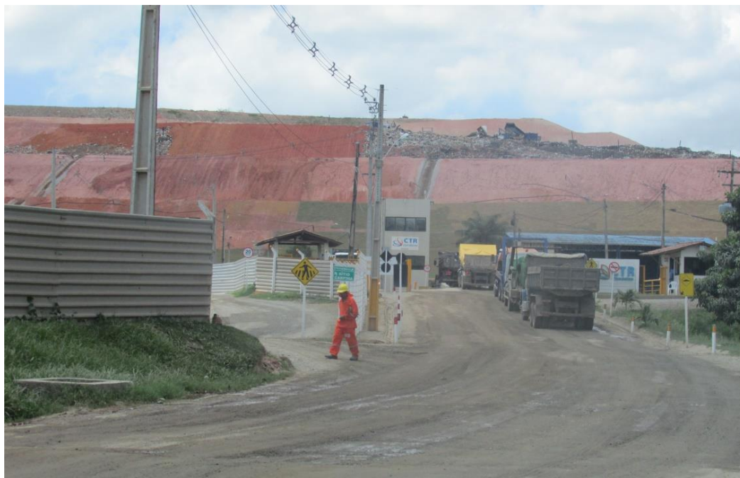
Figura 13 - Centro de Tratamento de Resíduos - CTR Candeias, no município de Jaboatão dos Guararapes – PE, 2019
