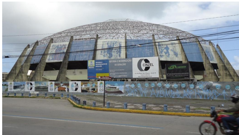
Figura 2 - Geraldão em reformas.
