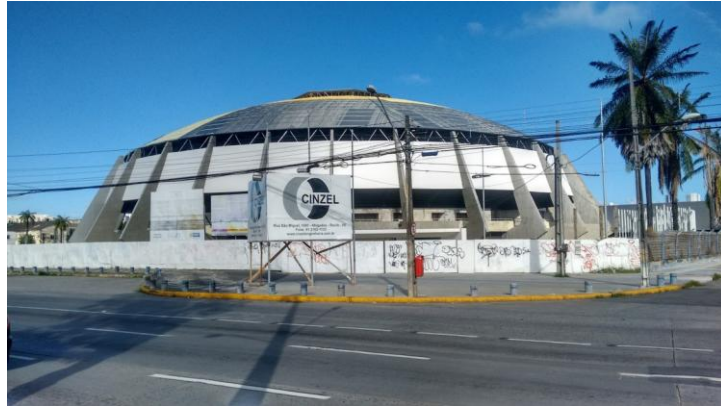
Figura 7 - Fachada do Geraldão
