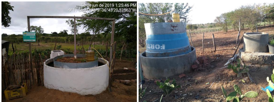
Figura 5 - Detalhe do tanque de fermentação, caixa de recarga e filtro de gás do biodigestor sertanejo. Sítio Angico e Sítio Cancelas, Bom Conselho-PE
