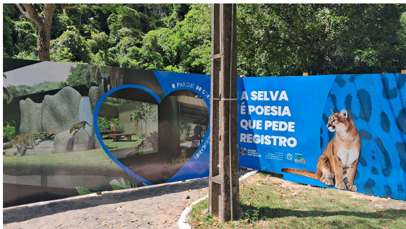
Figura 2: Obras em reforma e modernização dos recintos (Área dos Felinos)
