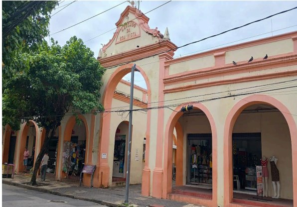
Figura 03 – Fachada do Mercado da Boa Vista
