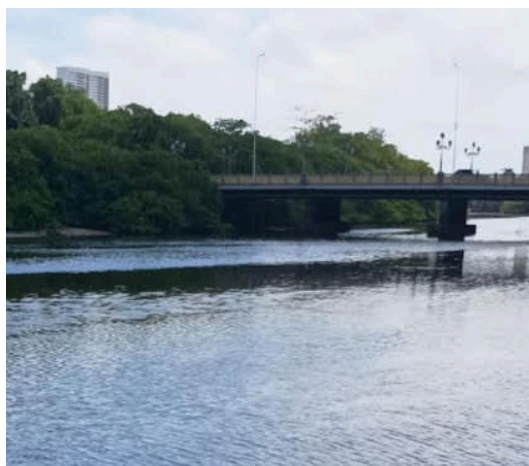
Figura 14 – Ponte 6 de Março - Recife - PE.
