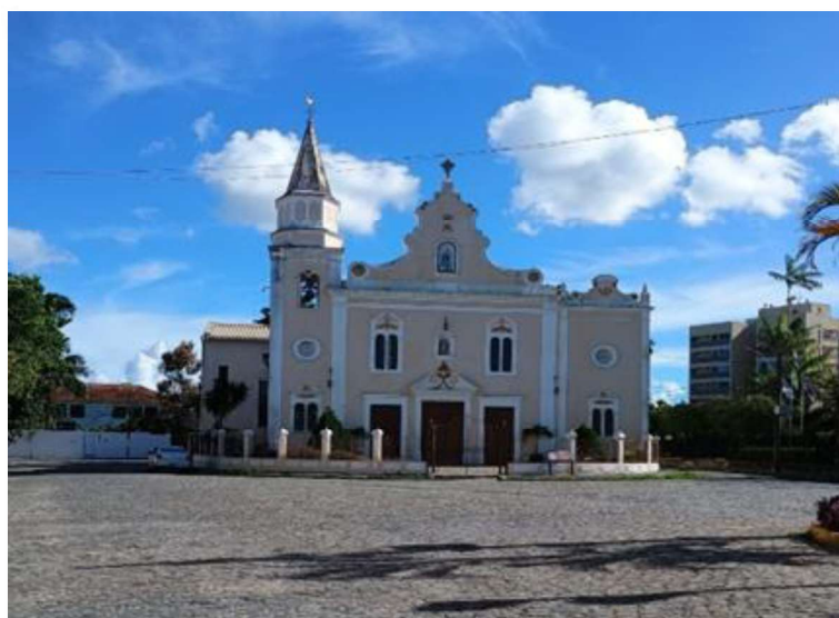
Figura 9 - Igreja Nossa Senhora do Rosário
