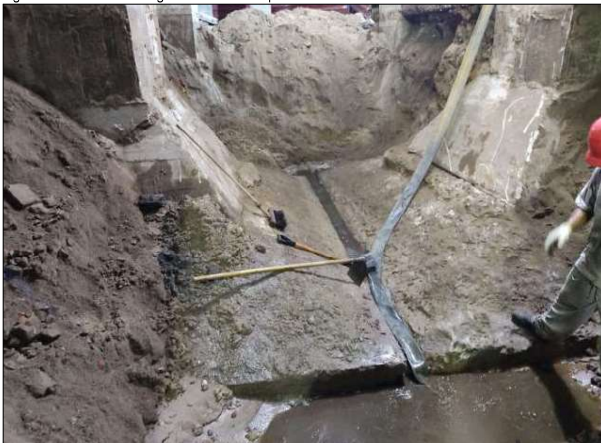
Figura 25: Levantamento geométrico das sapatas
