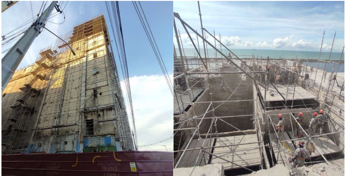
Figura 18: Estrutura de travamento dos andaimes para realizar a demolição do trecho 3
