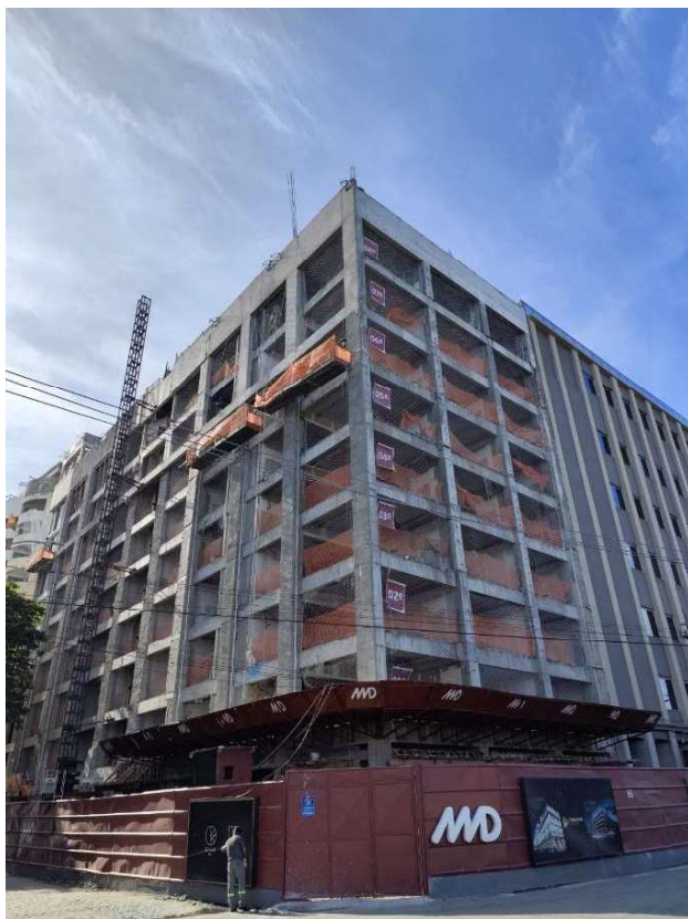
Figura 17: Trecho 3 com nova estrutura
