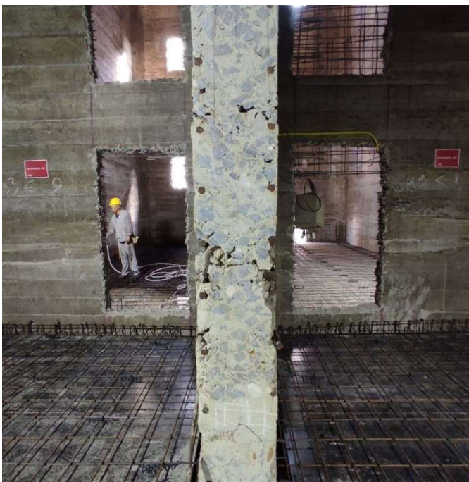
Figura 31: Laje engastada nas paredes de concreto pronta para ser concretada
