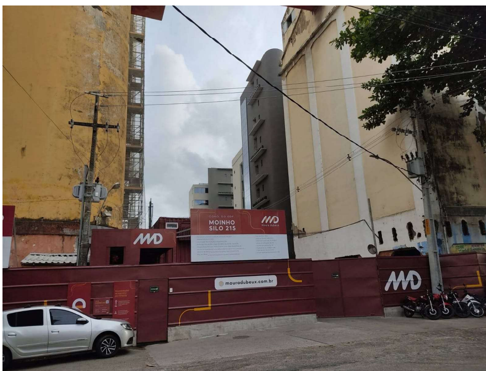
Figura 3 – Vista frontal da entrada da obra, interditando a Rua de São Jorge, localizada no bairro do Recife – PE
