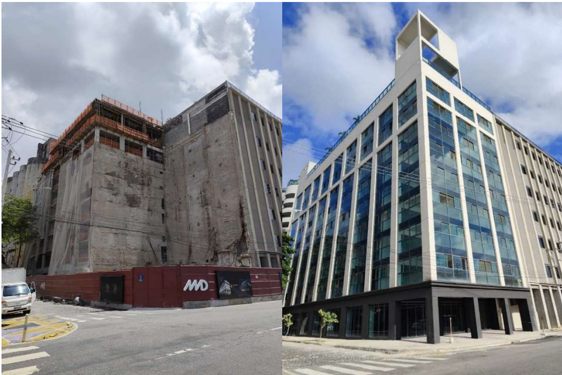
Figura 33: Vista frontal antes da demolição e pós conclusão
