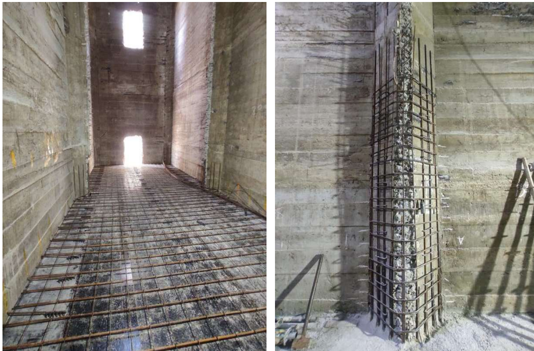
Figura 12: Foto da armação de reforço para criação dos Pilares e Armação das lajes integradas às paredes de concreto existentes
