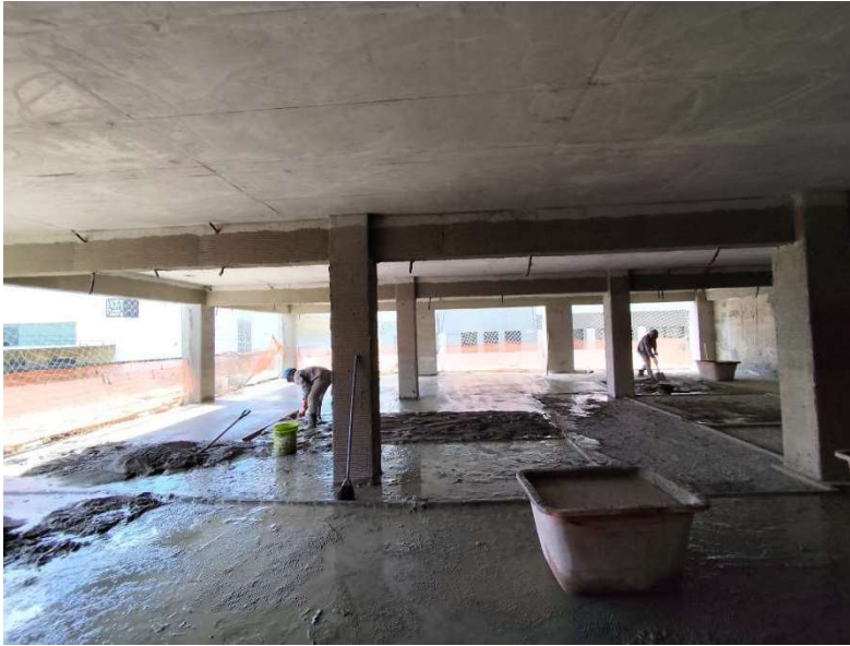
Figura 32: Trecho novo em execução do contrapiso
