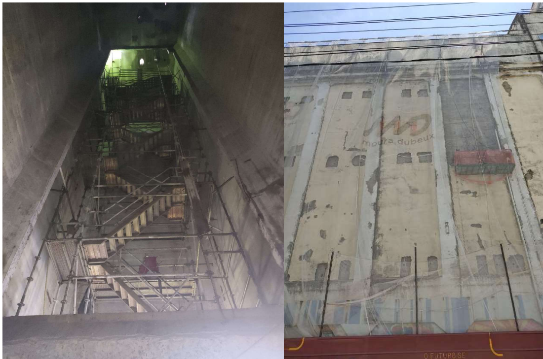
Figura 5: Balanças e Andaimes para acesso aos níveis mais altos dos Silos
