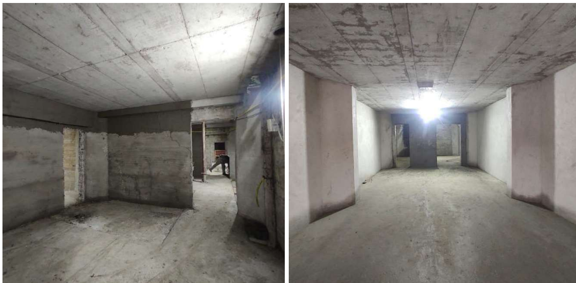
Figura 14: Ambiente interno já demolido mostrando apartamento 507
