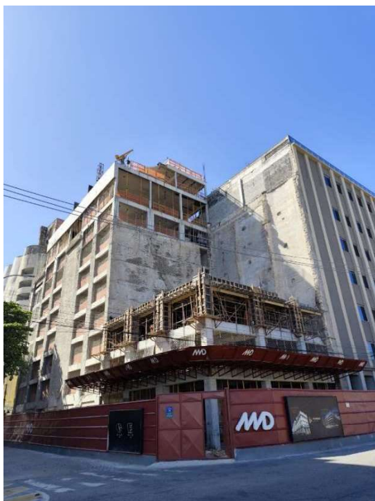
Figura 24: Forma em execução do 3º pav. Tipo
