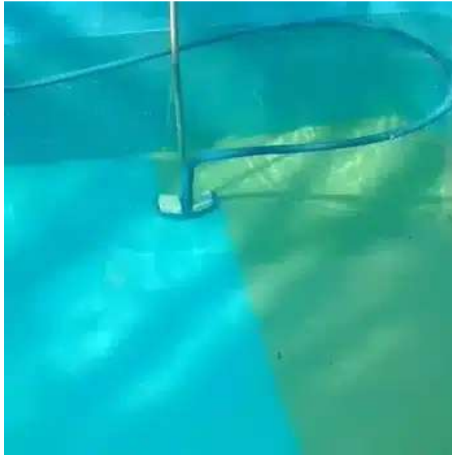
Figura 5. Piscina com material decantado.
