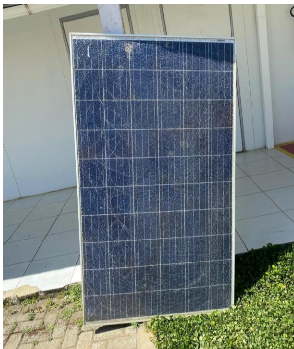
Figura 14– Módulo danificado utilizado na primeira substituição.
