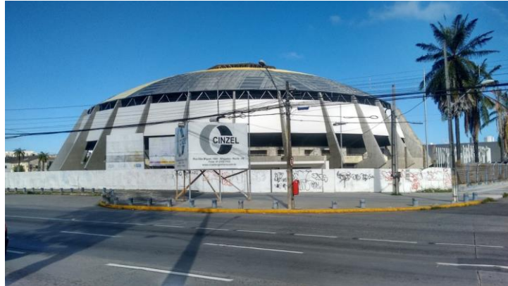
Figura 7 - Fachada do Geraldão
