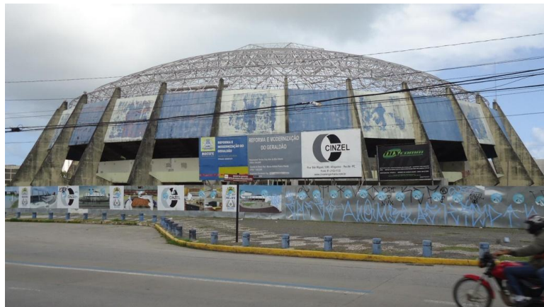
Figura 2 - Geraldão em reformas.
