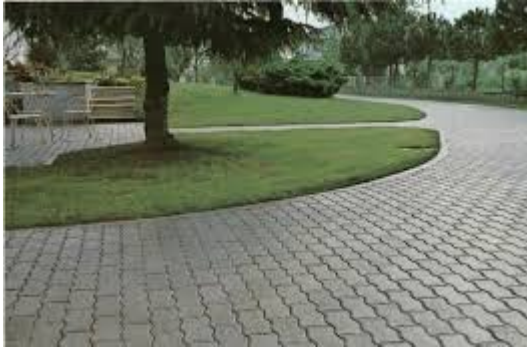
Figura 35 - Piso intertravado ecológico.
