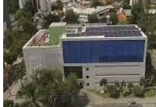
Figura 30 - Colégio Fazer Crescer, Recife com captação de energia solar.
