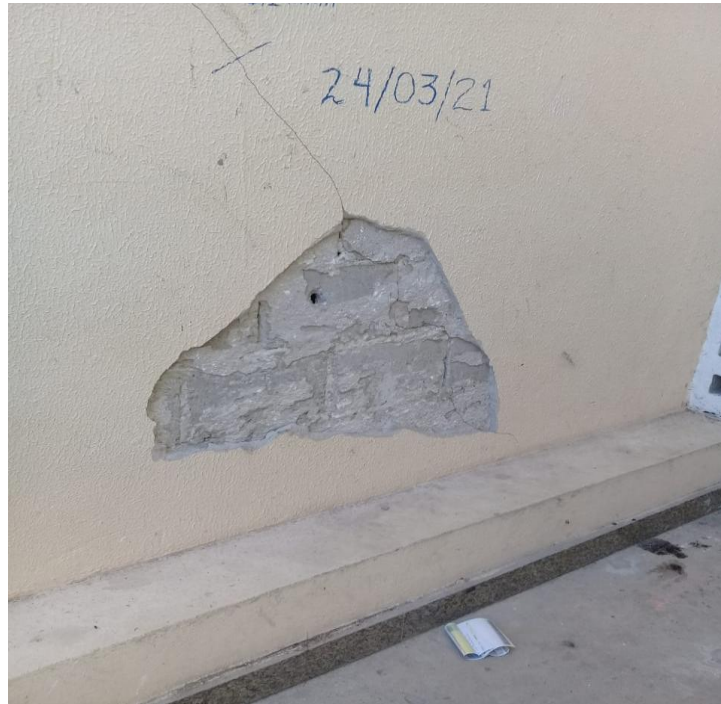
Figura 05 – Fissuras horizontais identificadas na fachada de um prédio caixão da Etapa III pertencente ao Residencial Jardins de Vitória.
