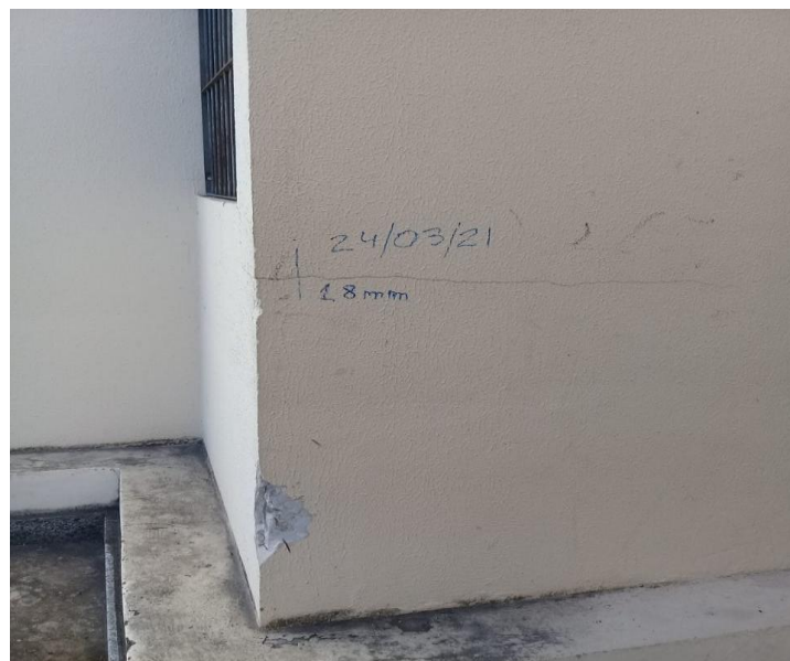
Figura 05 – Fissuras horizontais identificadas na fachada de um prédio caixão da Etapa III pertencente ao Residencial Jardins de Vitória.
